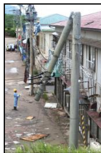
図8 突風により折損した配電柱 平成24年8月6日 新潟日報社 Web 版より
