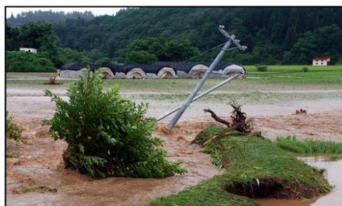
図2(4) 河川氾濫による電柱倒壊
