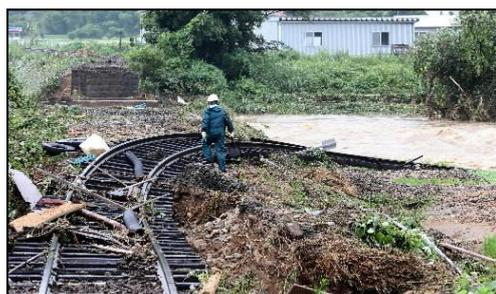
図2(3) JR山口線 鉄橋の流出
