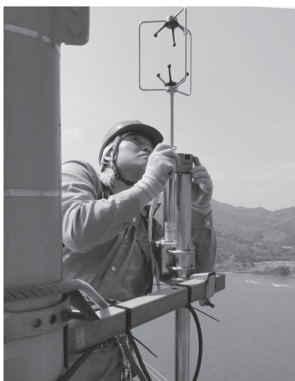
鉄塔上に超音波風速計を取り付け、腐食要因となる海風の状況を観測する様子
